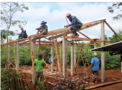
Đơn vị thi công đang lợp mái cho nhà trồng nấm. Tổng cộng có 50 nhà trồng nấm được trang bị cho 50 hộ gia đình để bắt đầu mùa nấm linh chi năm nay.
